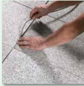
Fugentiefe durch PE-Rundschnur fixieren
