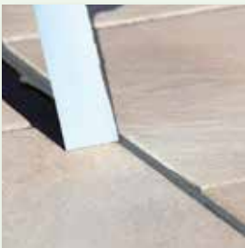
Klebebänder direkt im Anschluss entfernen
