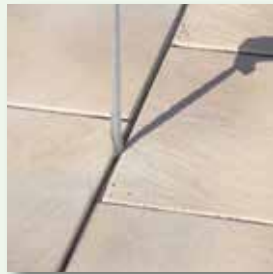
Fugenbandreste komplett entfernen
