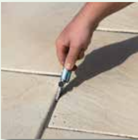
Hierzu Schnittkante FugenBand einkerben
