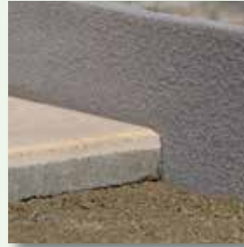
Anschließenden Belag druckfrei verlegen
