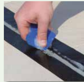
Fugenmasse verdichten und abziehen
