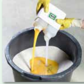
Die beiden Bindemittelkomponenten zumischen
