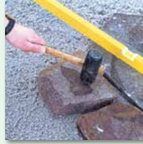
Beläge können mit Haftvermittler in den frischen Bettungsmörtel verlegt werden
