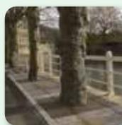
**Bordures d'arbres:** Grâce à sa haute perméabilité à l'eau, **vdw 520 Liant en résine bi-composantes pour agrégats** est idéal pour des bordures d'arbres. Son apparence exceptionnelle, sa facilité de nettoyage et sa durabilité extraordinaire garde la bordure d'arbre comme neuf, même après des années de service.
